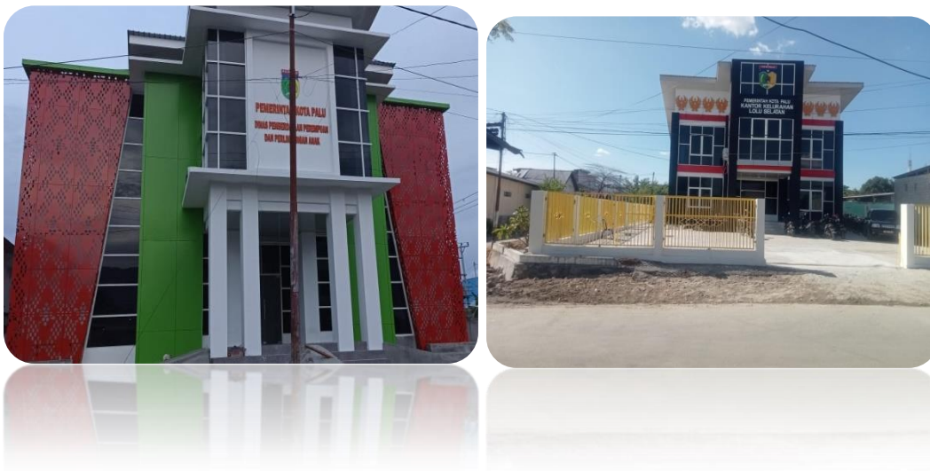
Gambar : 3.12 Pembangunan Gedung Kantor
